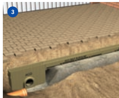
3 Placera en gavel i markrännans början. Markrännan läggs på plats med pilarna i den tänkta flödesriktningen. Tryck ner markrännan tills den når önskad höjd. OBS! Spaltgallret ska ligga minst 5 mm lägre än den omgivande beläggnings. Markrännorna skjuts ihop.
