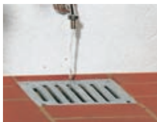
Punktavlopp med galvaniserat spaltgaller.
