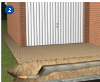
2 Blanda betong (fin eller grov) och häll betongen i kanalen. Betongens djup ska vara 80-100 mm.
