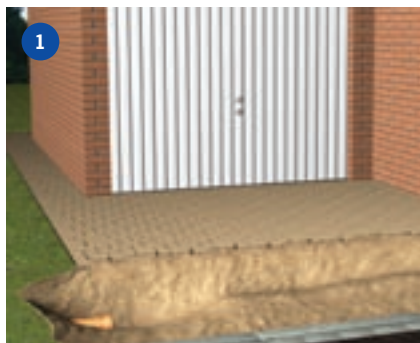
1 Gräv en 200-250 mm djup kanal till markrännan. Vid ett ev. sandfång ska djupet vara 400-450 mm.
